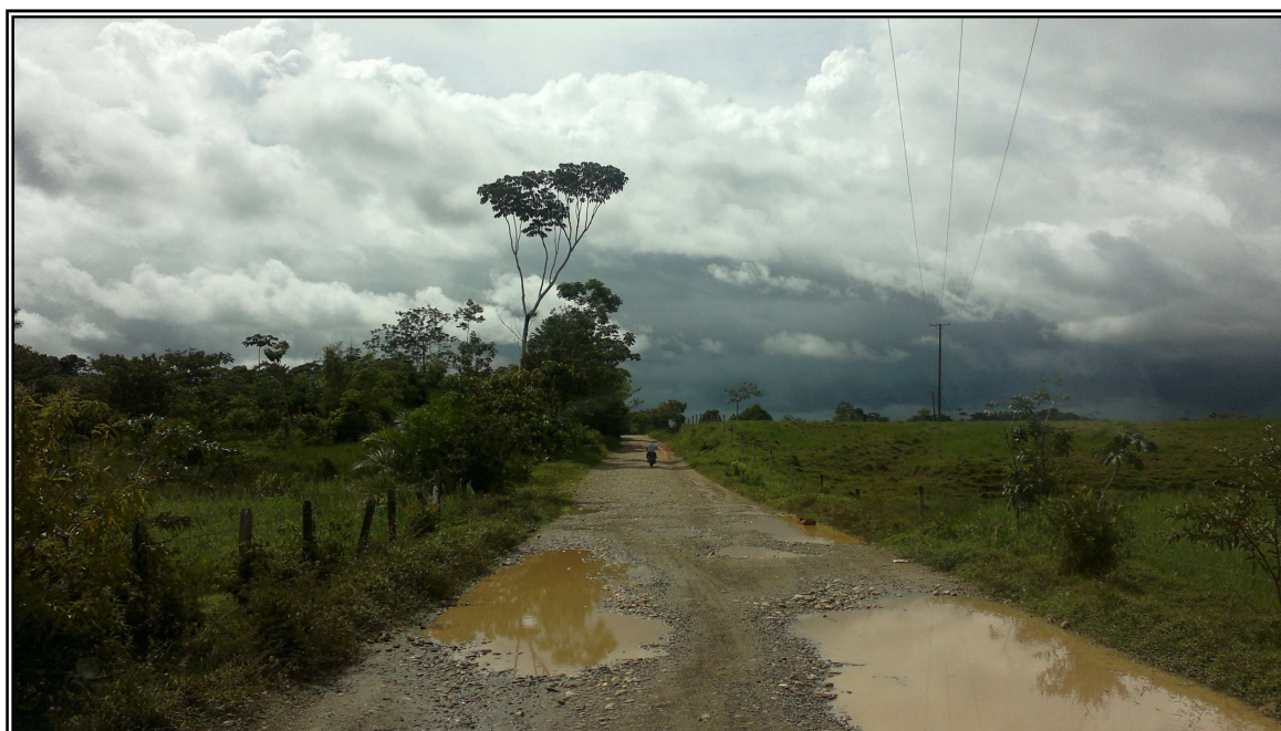
Foto 3. Estado actual carretera Puerto Asís – Muelle Esmeralda, 12 de Marzo de 2012.
